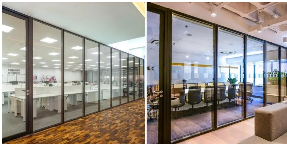
Figura 12: divisória encaixilhada de vidro
